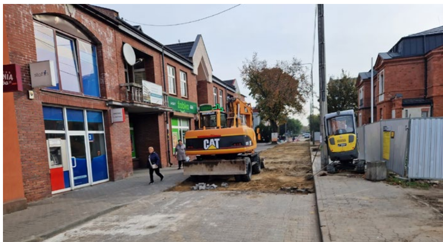
Remont drogi gminnej ul. Sienkiewicza
