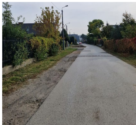
Przebudowa ul. Staszica na odcinku od ul. Engelmana
