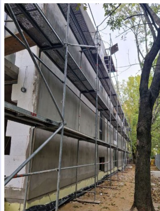
Kończenie prac na budowie Szkoły Podstawowej nr 2
