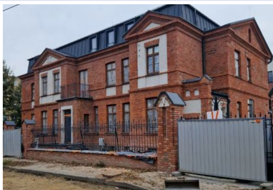
Obecny stan budynku Sienkiewicza 4 z odnowionym ogrodzeniem
