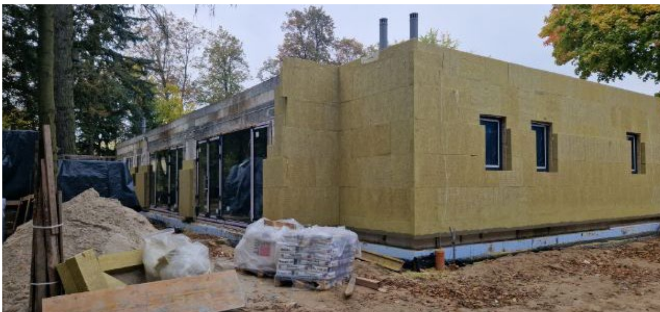
Trwające prace elewacyjno-ociepleniowe na budowie przedszkola w Radzikowie
