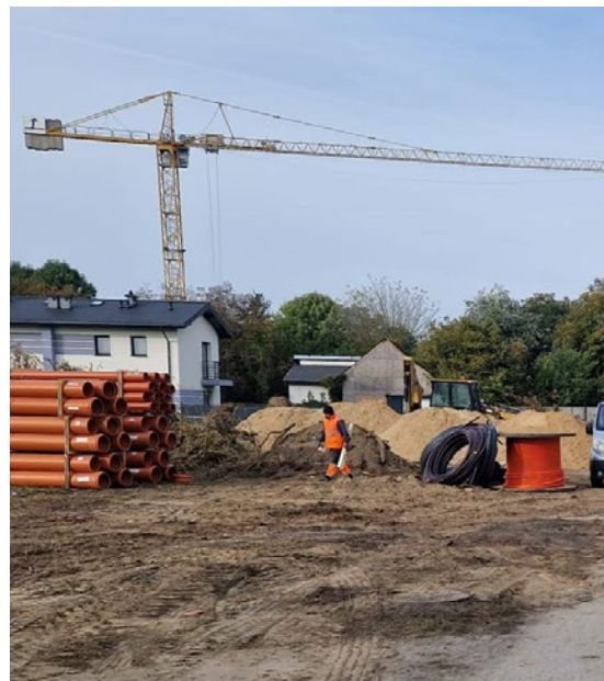
Przebudowa ul. Staszica na odcinku od ul. Engelmana
