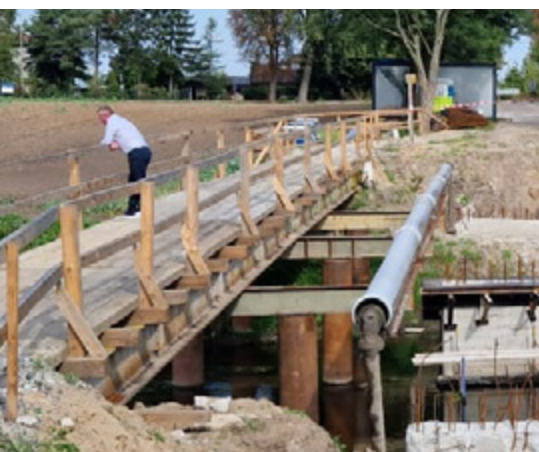
Nowy Łuszczewek - rewitalizacja mostu
