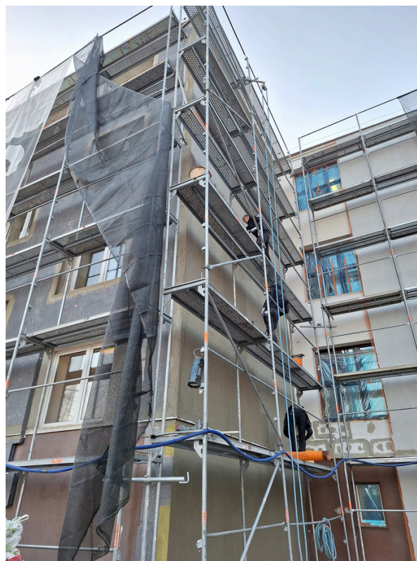
Termomodernizacja, budynek LO i SP3
