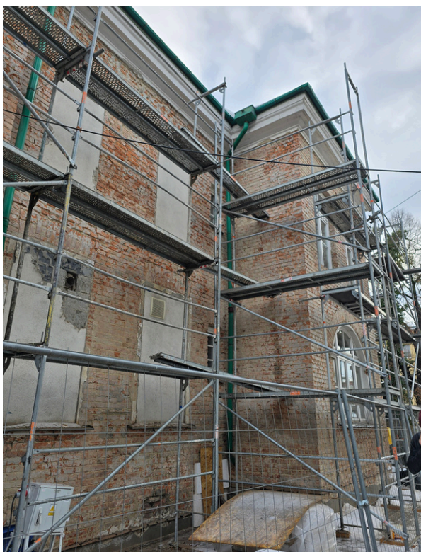
Termomodernizacja, budynek SP4
