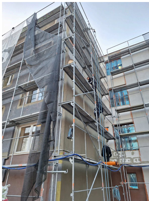
Termomodernizacja, budynek LO i SP3
